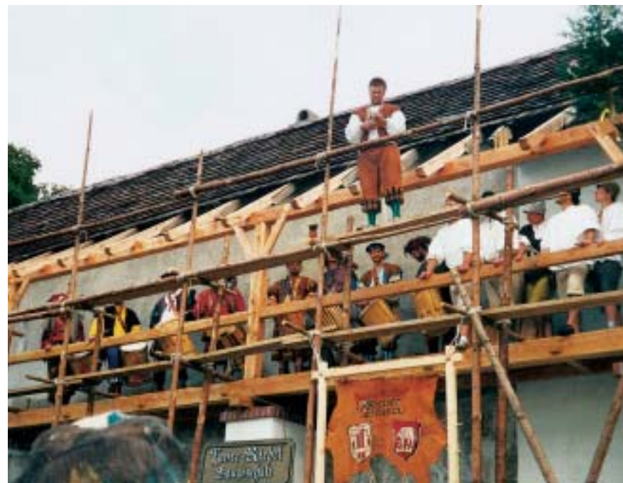
Neubau des alten Wehgangs.
